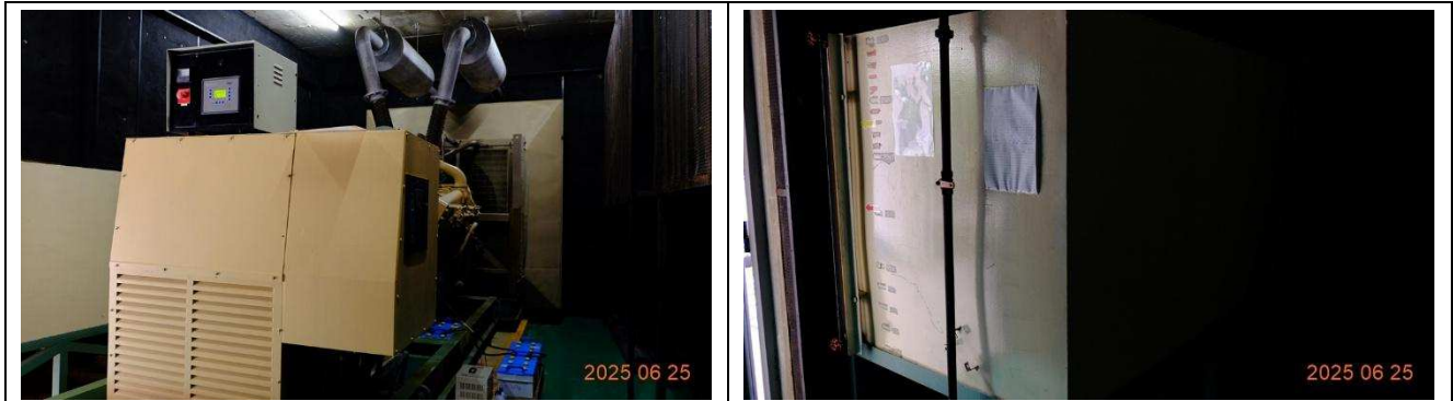
เครื่องกำเนิดไฟฟ้าฉุกเฉินขนาด 500 KVA
